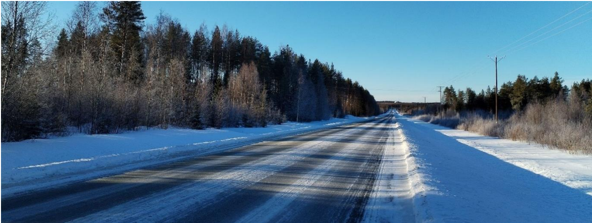
Kuva 28. Kokkolantien tiemaisemaa lännen suuntaan. Tie on metsän rajaama. Tien pohjoislaidalla kulkee pieni sähkölinja. Tien varressa puusto on paikoin matalaa ja pusikkoista.
