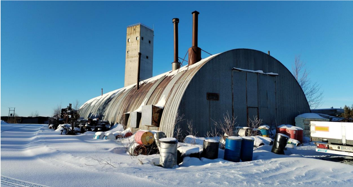
Kuva 47. Teräsrunkoinen, peltiverhottu kaarihalli sijaitsee pienen matkan päässä kaivostornista.
