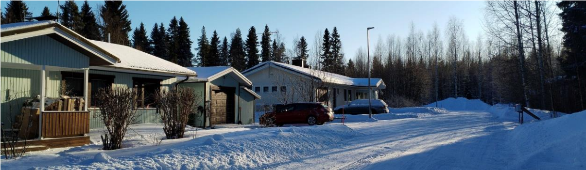
Kuva 36. Pientaloja Vaahdottajantien varressa, asuinalueen kaakkoiskulmalla.
