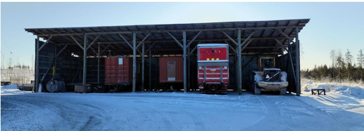
Kuva 48. Toiselta pitkältä sivultaan avoin konekatos on teräs rakenteinen, julkisivut ovat peltiä.
