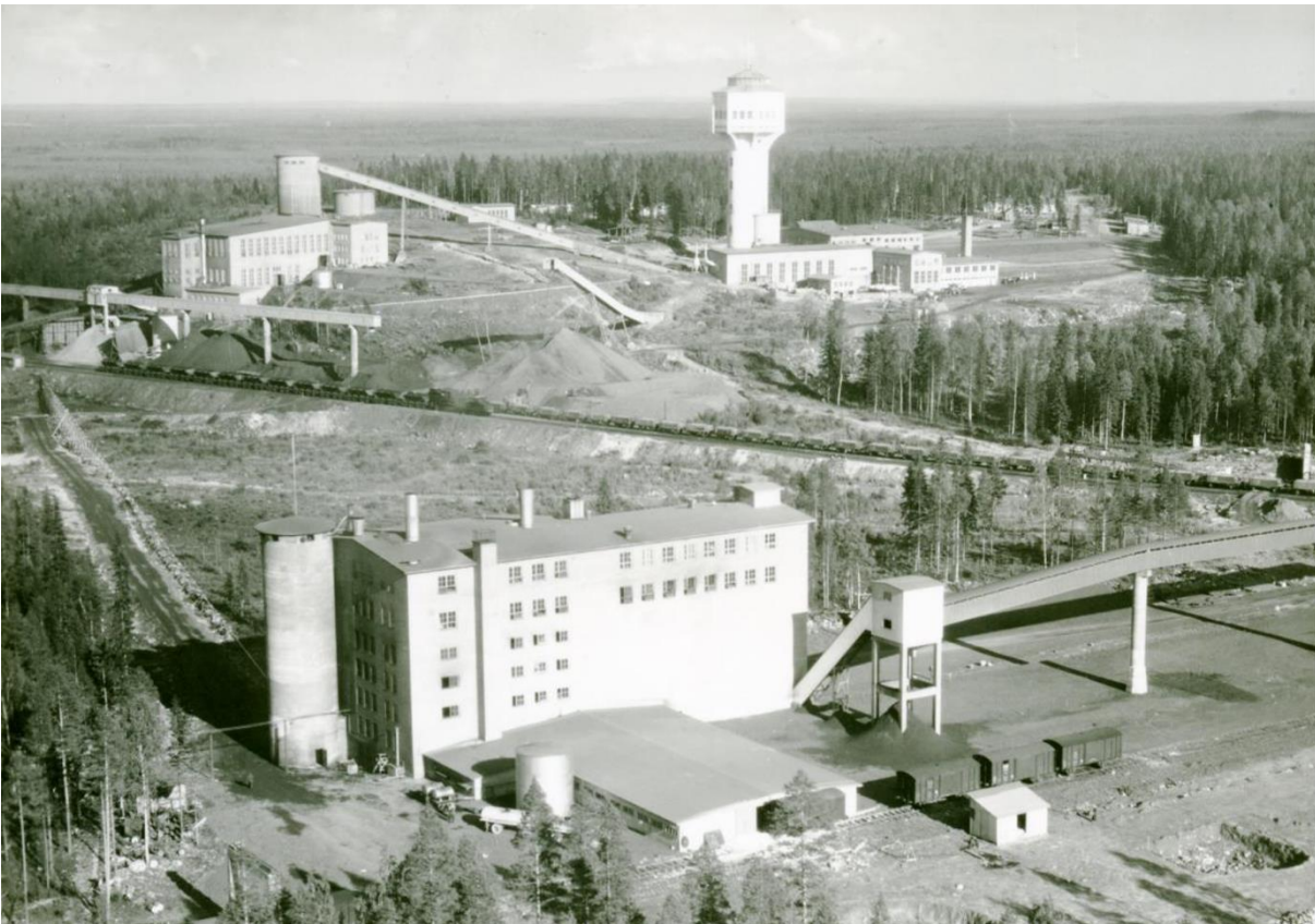
Kuva 50. Ilmakuva kaivosalueen rakennuksista (kuva: Kainuun Museo).
